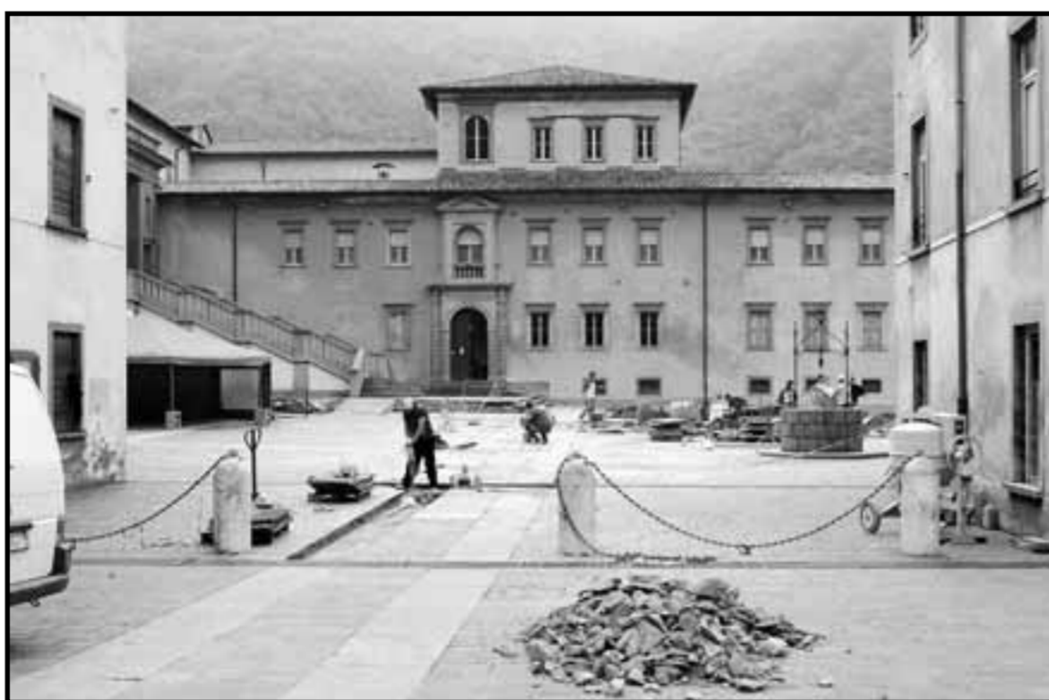
Lavori in piazza del Giuramento (foto Magni)
